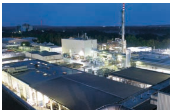
Industrie-Recycling-Zentrum Bramsche: In Bramsche können mehr als 600 gefährliche Abfälle zuverlässig verwertet oder beseitigt werden. Die Hochtemperatur-Verbrennungsanlage (HTVA) am Standort kann auch reaktive und toxische Chemikalien bei Temperaturen von über 1.000 °C thermisch behandeln
