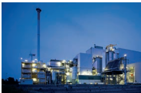
Sonderabfallverbrennungsanlage SAVA: Die SAVA in Brunsbüttel ist auf die fachgerechte und umweltschonende Verbrennung besonders gefährlicher Abfälle spezialisiert. Sie zählt zu den modernsten und leistungsfähigsten Anlagen Europas zur Behandlung fester, flüssiger und pastöser Sonderabfälle
