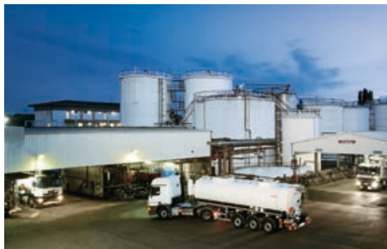
Entsorgungszentrum Herne: Das Entsorgungszentrum Herne ist vor allem auf die Aufbereitung, Konditionierung, Neutralisierung und Entgiftung gefährlicher Flüssigkeiten und pastöser Stoffe ausgelegt. Das Fass- und KTC-Lager hat eine Kapazität von 240 Tonnen, das Tanklager fasst bis zu 22.000 Kubikmeter
